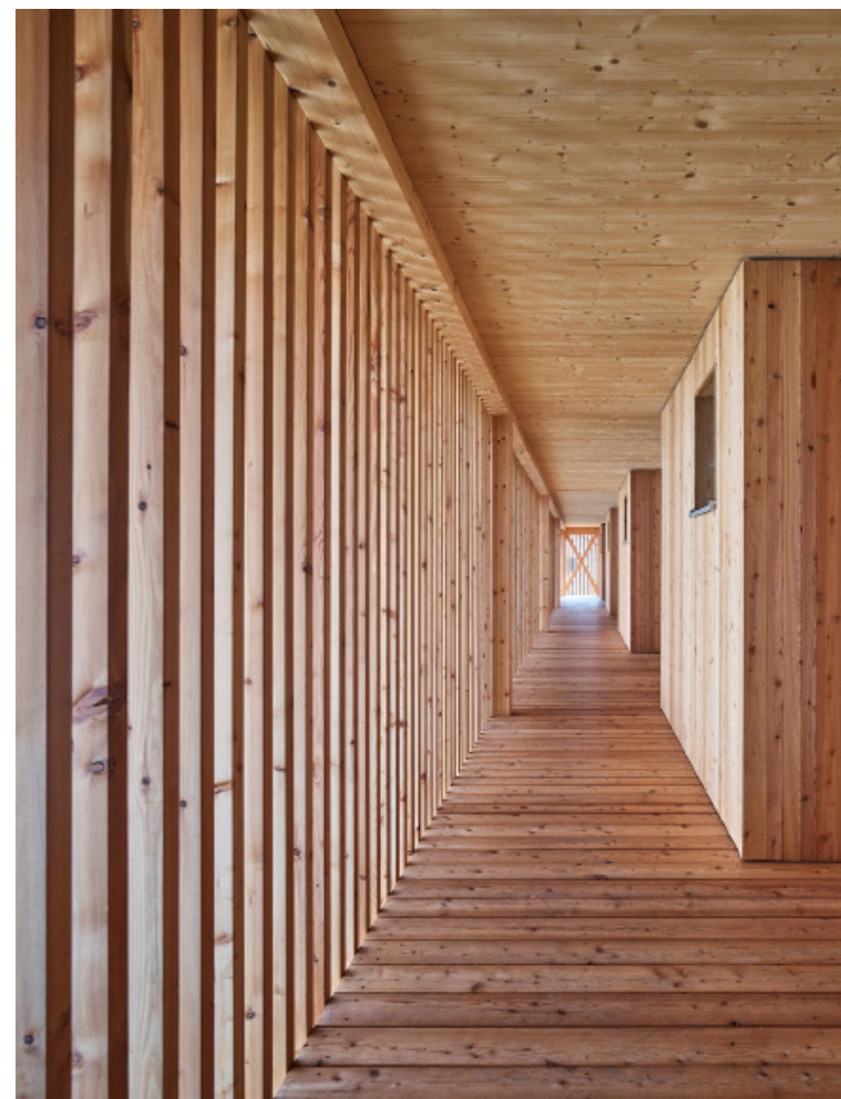
Ein Laubengang mit Lärchenholzslattung erschließt die Wohnungen im Obergeschoss des Langhauses. An arcade with larch slats opens up the apartments on the upper floor of the long building.
