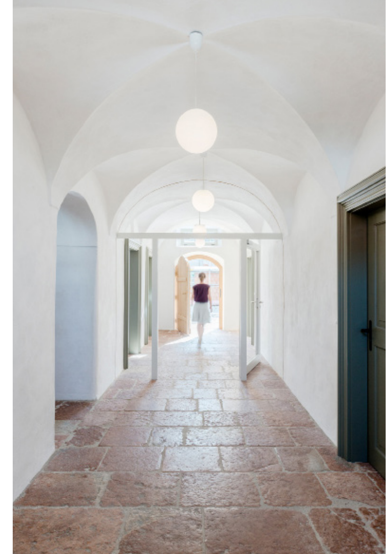
Die Bodenplatten wurden ausgebaut, gereinigt und wieder exakt eingefügt. The floor tiles were removed, cleaned, and returned to their original positions.
