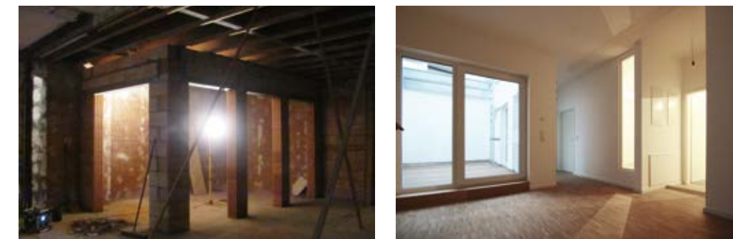
BV 230: Durch die Herausnahme eines Teils der Decke und den Einbau eines Atriumhofs wird der bislang tageslichtfreie Bereich der Immobilie nun lichtdurchflutet und einen blickgeschützten Außenbereich gibt es dazu.
