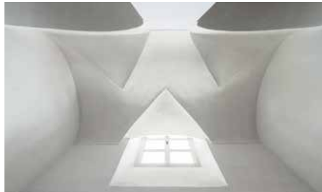
Massive Gewölbe im bestehenden Treppenhaus
