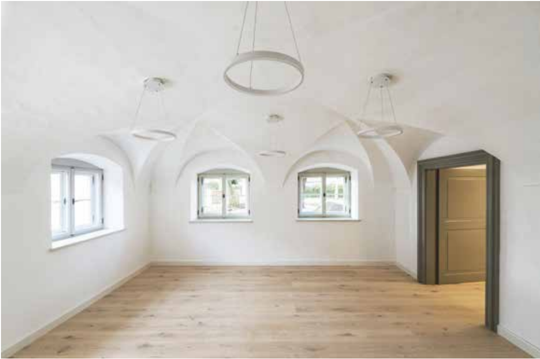
Als innerer Flügel der neuen Kastenfenster wurde Isolierverglasung eingesetzt und gezogenes Glas mit Sprossenteilung in das äußere Element.
