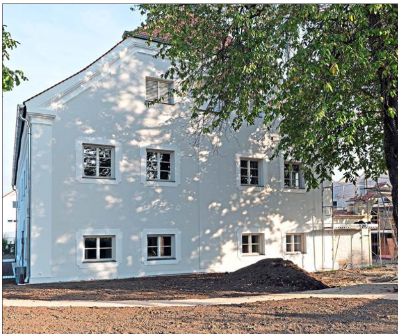
Das Wohnhaus des denkmalgeschützten Stadlerhofs wurde aufwendig und liebevoll saniert. Dafür gab es einen Preis. – F.: Antje Hanebeck
